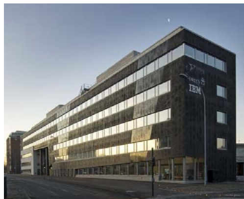
Professor Brochs gt.2 sett fra nord-øst. Bildet viser østfasaden for den høye fløyen (Foto: KLP Eiendom)
