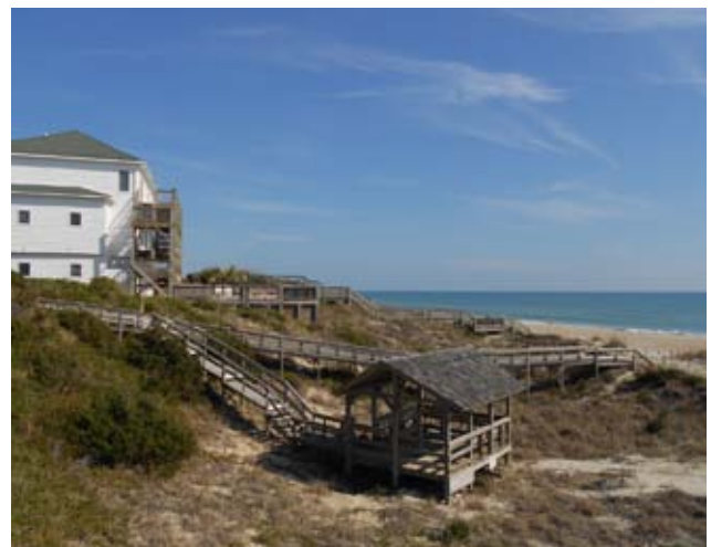
4.3 > Bebauung einer Düne in Atlantic Beach, North Carolina
