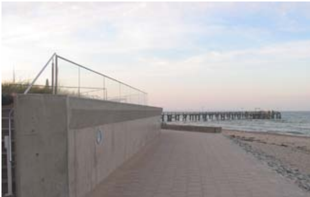
1.9 > Beispiel für eine kombinierte Ufermauer vor dem Hotel Bellevue, Scharbeutz (SH)
